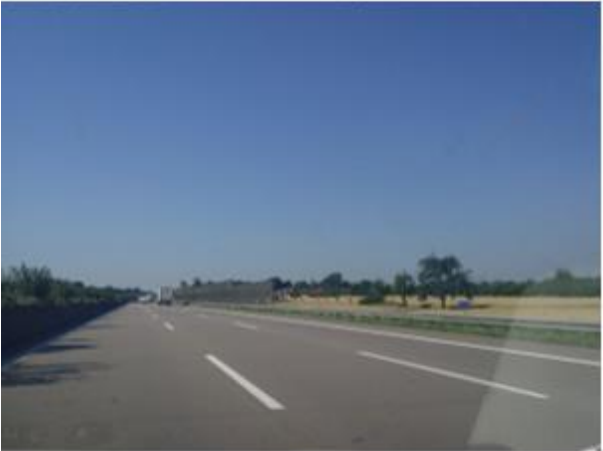
Yerleşim Alanı Geçişinde Gürültü Perdeleri Uygulaması
