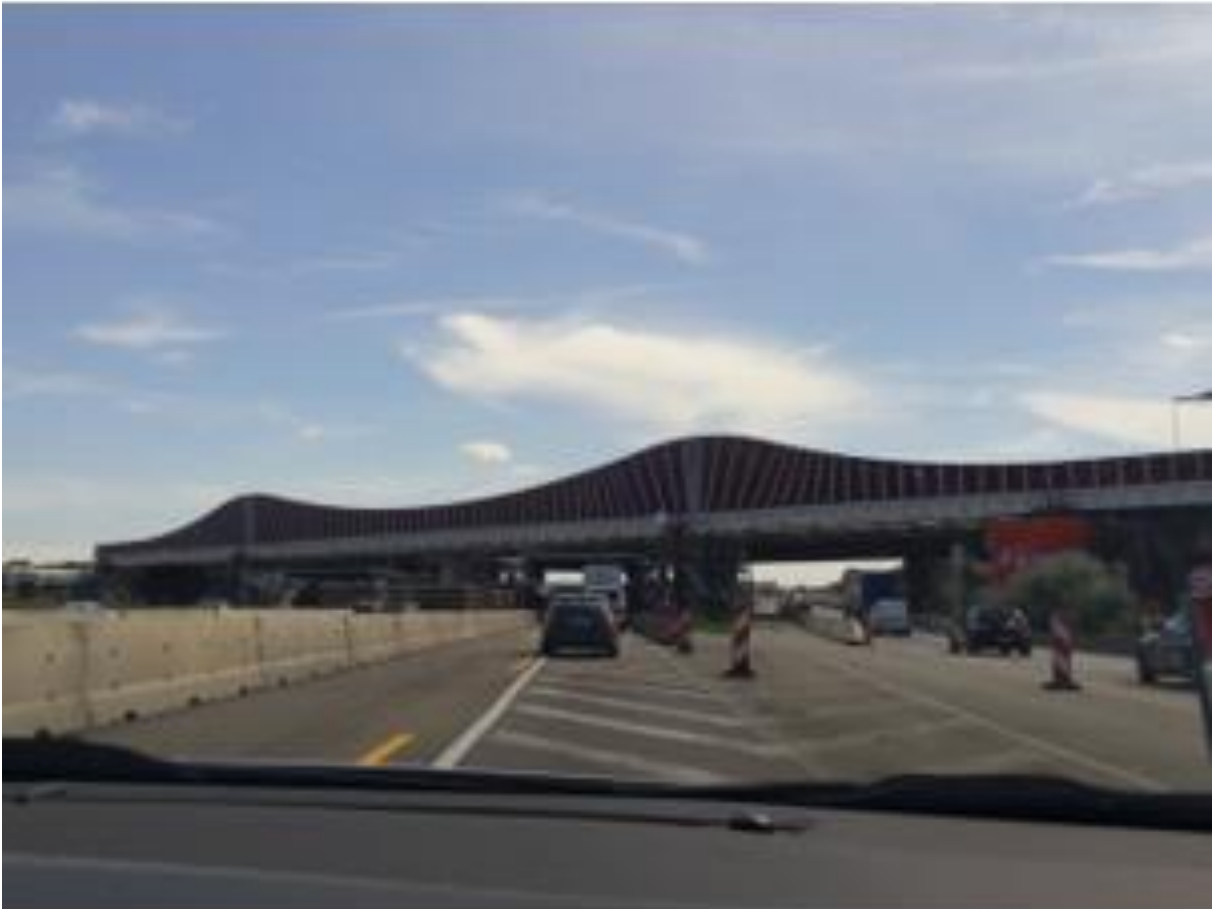
İşleyen Trafikte Çelik Üstgeçit Köprüsü Yapımı
